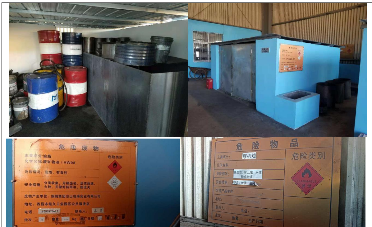
图 3-1 瑞海公司冶金材料分公司的废机油危废暂存间
